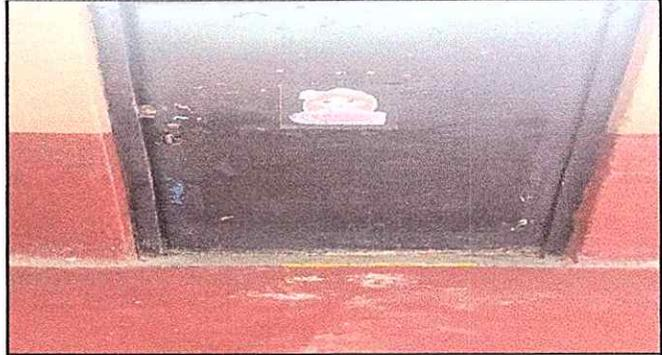
Foto 2: Se observa el deterioro de las puertas, sin chapas y seguridad en el modulo 1
