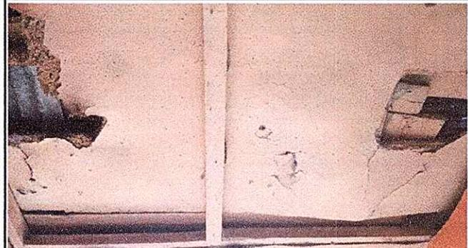
Foto 4: Se observa el mal estado del techo, con deterioro y picado formando unos hoyos modulo 1
