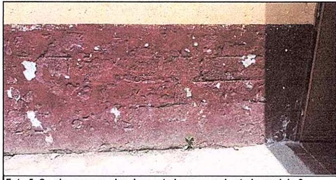
Foto 5: Se observa paredes desgastadas y en mal estado modulo 2
