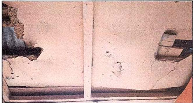
Foto 4: Se observa el mal estado del techo, con deterioro y picado formando unos hoyos modulo 1
