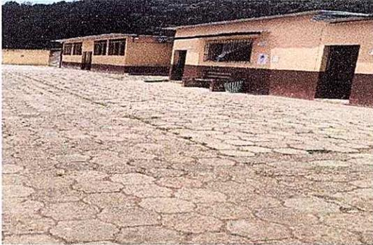
Foto 1: Se observa el espacio en el corredor la necesidad de entechado y columnas, ya que se acumula agua formando charcos, provocando lodo en varias partes en el modulo 2
